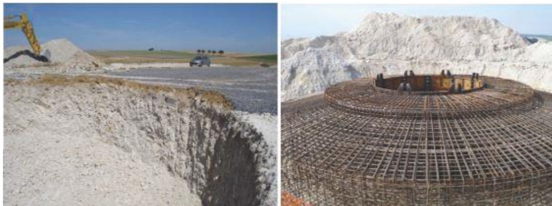
Figure 7 : Construction des fondations (wpd)
