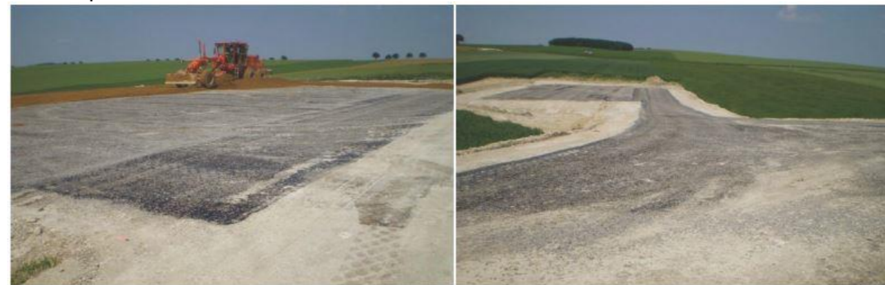
Figure 6 : Aménagement des plateformes de grutage (wpd)
