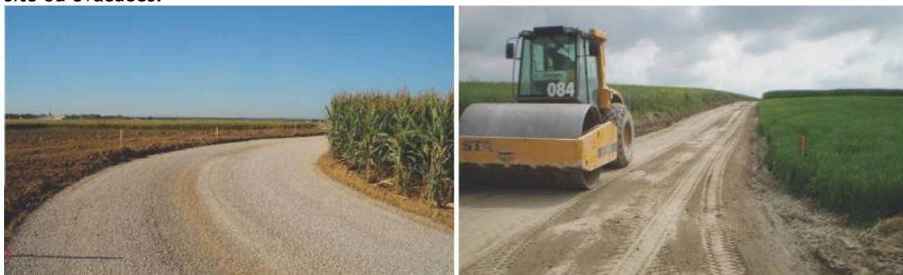
Figure 5 : Aménagement des chemins d'accès d'un parc éolien (wpd)
